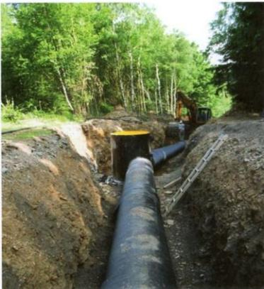
Ils sont utilisés également pour le déchargement des liquides et des substances gazeuses dans la mer. Pour la fabrication de telles canalisations, ITP offre des avantages considérables tel que l'élasticité de la canalisation donc une adaptation optimale à la superficie, poids léger, jonction fiable et solide, résistance à l'eau de mer et rigidité annulaire spécialement adaptée.
