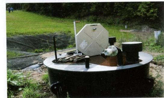
Le cône Pe qui a été spécialement conçu pour les regards Pe et PP a les mêmes caractéristiques que le couvercle précédemment cité. Ces couvercles sont plus appropriés pour l'installation des routes, puisque le couvercle est intégré dans l'asphalte et connecté au regard d'une manière flexible (télescopique). Il est possible de choisir entre les couvercles représentés dans le tableau ci-contre.
