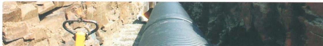
Les tubes résistent jusqu'à la température de 60°C ainsi qu'aux matières chimiques contenues dans les eaux usées et présentent une grande résistance contre la corrosion. Les conduites annelées se déforment en souplesse sous l'effet des charges brusques ; absorbent ainsi les chocs, puis reprennent leur forme initiale grâce à la structure moléculaire du polyéthylène, et ce pendant au moins 50 ans.
