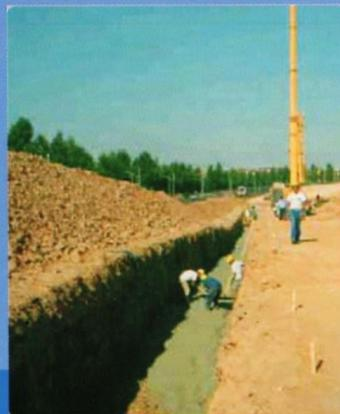
Tube de 2m de longueur, pour chaque raccordement on installe 4m de conduite. Il est nécessaire de réaliser un lit de béton au fond de la tranchée.
