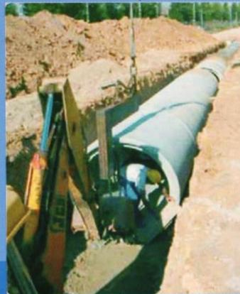
Nécessite une large tranchée qui permet le passage de moyen mécanique pour poser le tube. Utilisation de deux moyens mécaniques, grue pour le soulèvement et pelleuse pour poser le tube.
